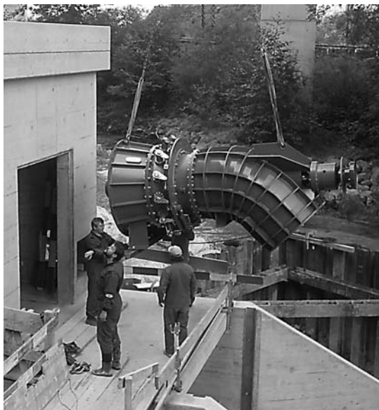
Arrivée de la turbine
