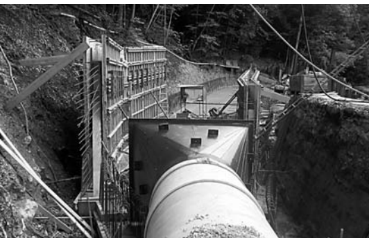
Construction des ouvrages à la prise d'eau
